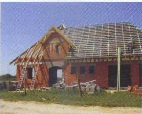
Melania w budowie
