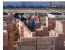
Fot.1 Budowa domu (Intro Media)
